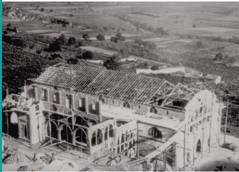
Arxiu personal de Joan Fuguet i Sans. Barberà de la Conca. Autor desconegut. El "Celler dels pobres" durant les obres de construcció, obra de Cèsar Martinell. Barberà de la Conca (Conca de Barberà), 1920
