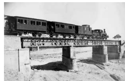
El pont de ferro sobre la riera de La Bisbal al Vendrell, construït el 1864, i destruït el 20 de gener de 1939 per les tropes republicanes. Fotografia d'autor desconegut. 1905. ACBP. Col. Felip Nin Esteban.
