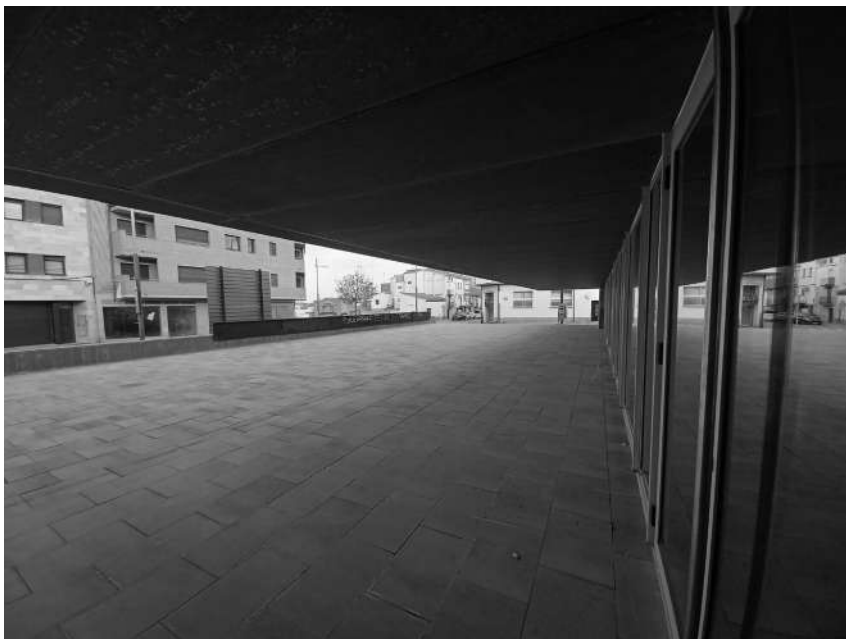
Sistema de protecció impacte llum solar a Arxiu Comarcal de les Garrigues
