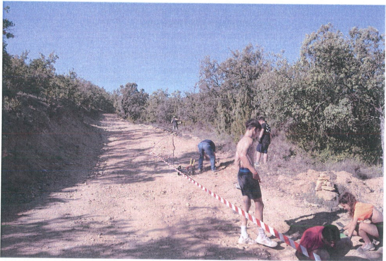
Camí romà. Camp de treball de juliol de 2022. Punt d'intersecció entre el camí vell, empedrat, i el camí forestal nou per on circulen els vehicles. Aquest punt conflictiu no ha estat solventat encara. La via romana resta protegida només per unes valles que no impedeixen l'accés dels vehicles i motos al camí romà.
