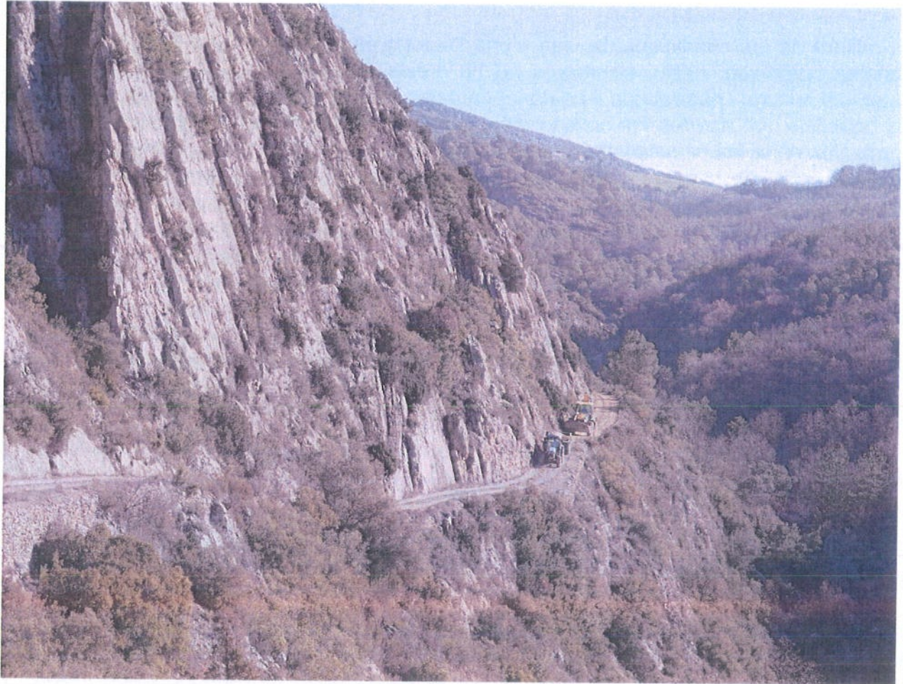
Treballs de manteniment al Pas del Llop (2023)
